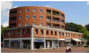
Rundbau am Wulfener Markt
